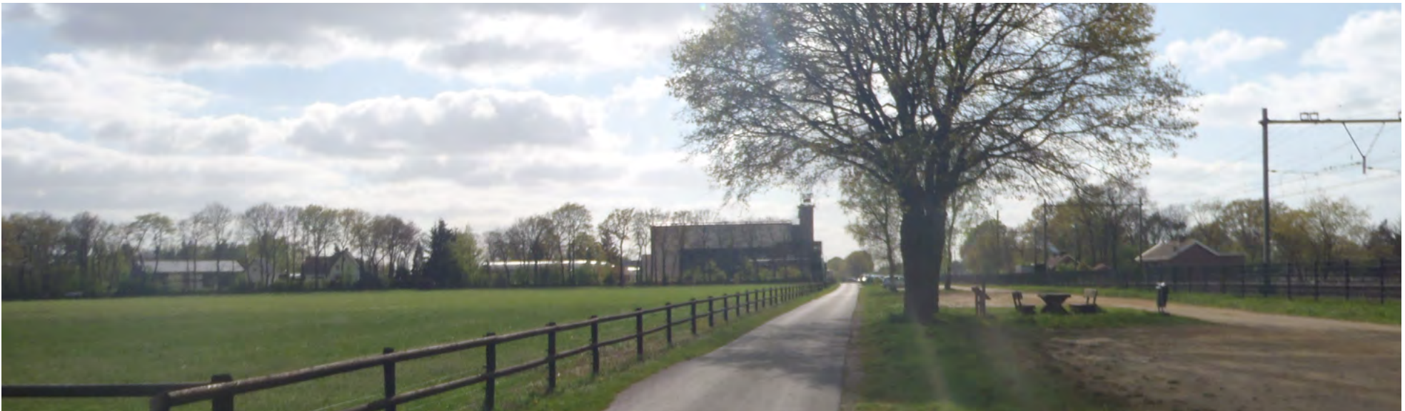
Zicht op de bestaande bedrijfsgebouwen Twilmij (bron: google earth)
