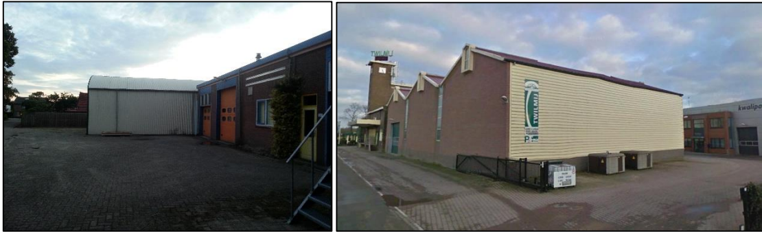
Indrukken van het plangebied (achterzijde (links) en de voorzijde aan de Houtbeekstraat (rechts)).
