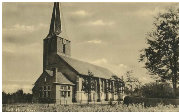
Afb. 2.22: Zuidwestgevel van de kerk, rechts een haag tussen het oude kerkepad en het pastoriebos, z.j. (Herkomst: qoop.nl, gedateerd door qoop.nl op 1967.)
