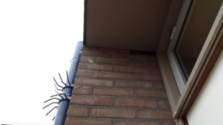
Foto 5: Ruimte bij de daklijst van schoolgebouw. Mogelijk een geschikte ruimte voor vleermuizen.
