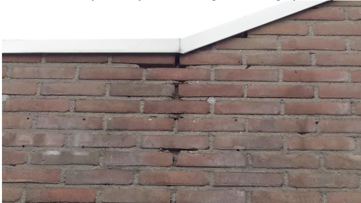
Foto 6: Noordzijde van het schoolgebouw met stootvoegen. Spouwmuur mogelijk geschikt als verblijfplaats voor vleermuizen.
