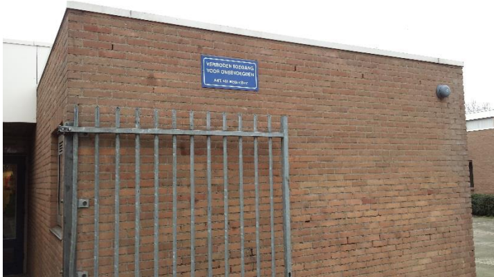
Foto 6: Noordzijde van het schoolgebouw met stootvoegen. Spouwmuur mogelijk geschikt als verblijfplaats voor vleermuizen.
