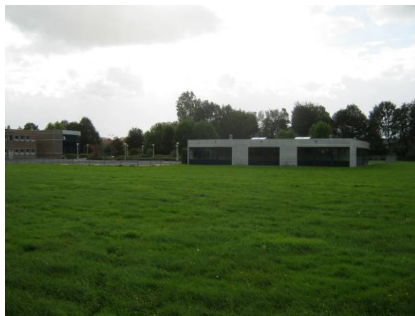
Foto 2: Overzicht (vanuit noorden) deellocatie B
