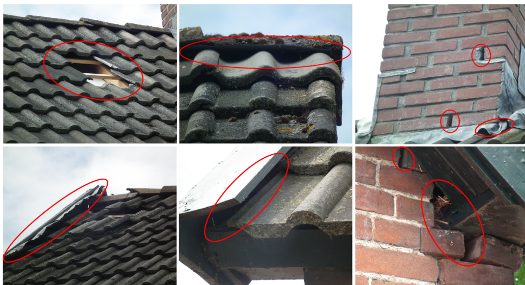
Figuur 3 In de bebouwing van de planlocatie zijn verschillende openingen die mogelijk geschikt zijn als vaste- rust en/of verblijfplaats voor vleermuizen (rood omcirkeld).
