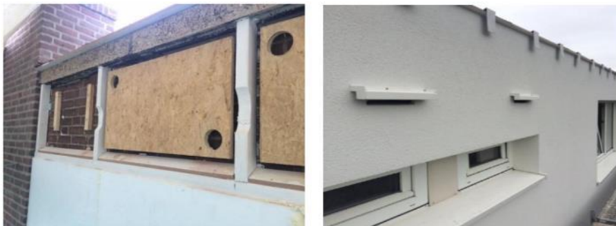
Figuur 21: Voorbeeld vleermuisverblijf in de voorgevel. Let op dat er voldoende ruimte is tussen dak en uitvliegopening in verband met predatie vanaf het dak. (Bron: Arcadis)
