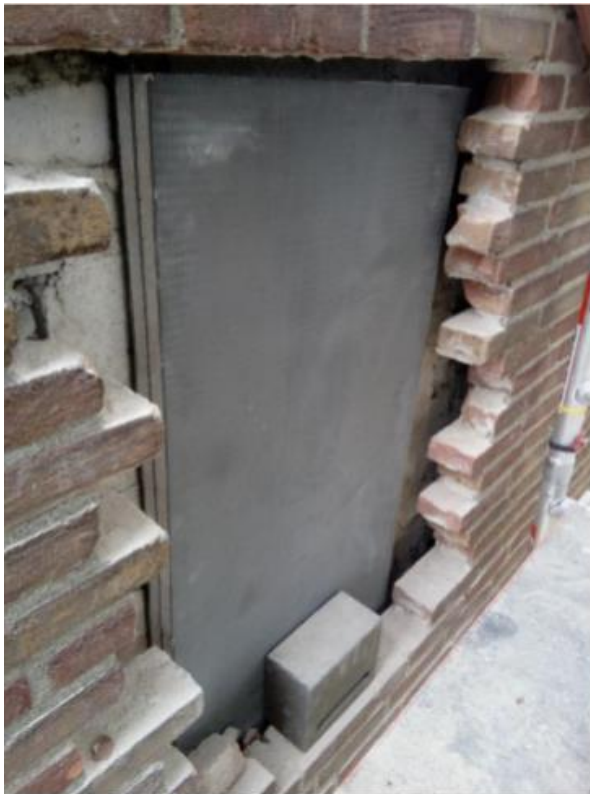
Figuur 20: Vleermuisverblijf in gevel met inbouwmodule Miecon en entreesteen (Bron: Arcadis)
