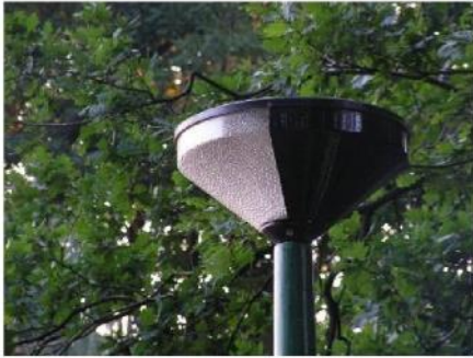
Figuur 31: Afgeschermd verlichting om zo te voorkomen dat verlichting het leefgebied van vleermuizen inschijnt (Bron: vleermuizenindestad.nl).
