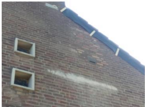
Figuur 20: Vleermuisverblijf in gevel met inbouwmodule Miecon en entreesteen (Bron: Arcadis)
