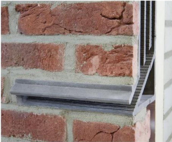
Figuur 19: Ingebouwd Tichelaar prefab verblijf. Voorbeeld geschikt als kraamverblijfplaats. Bron: Koninklijke Tichelaar Makkum.
