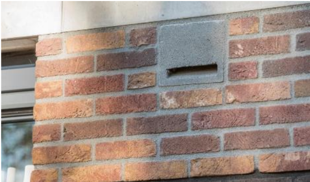
Figuur 17: Entreesteen in een spouwmuur (Bron: Vivara Pro)
