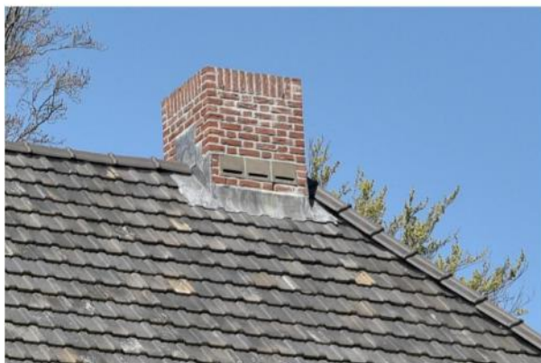
Figuur 25: Entreestenen om een schoorsteen vleermuisvriendelijk te maken (Bron: Vivara Pro).
