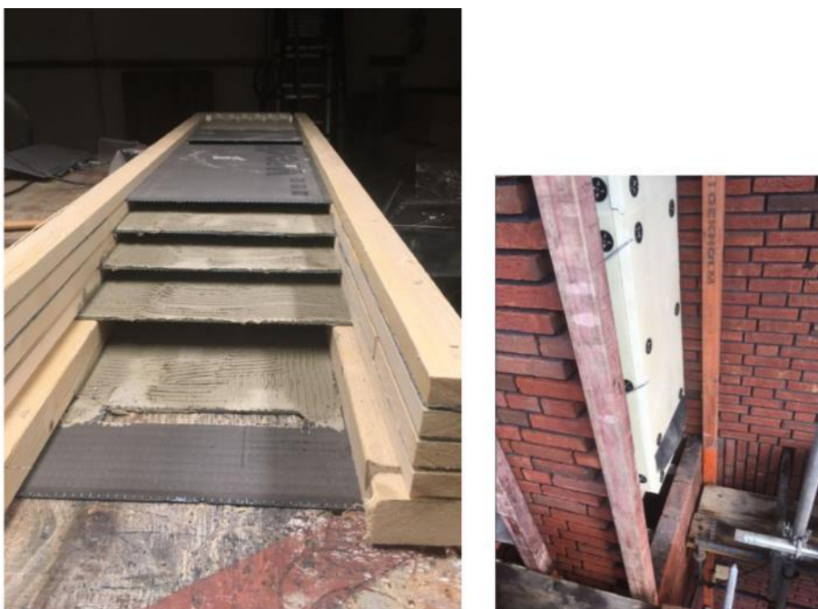
Figuur 22: Uitvoeringsvoorbeeld project met foto's van de vleermuiskast ten behoeve van massa-winterverblijf. De platen hier zijn extra opgeruwd met tegellijm zodat vleermuizen grip kunnen krijgen (Bron: Arcadis)
