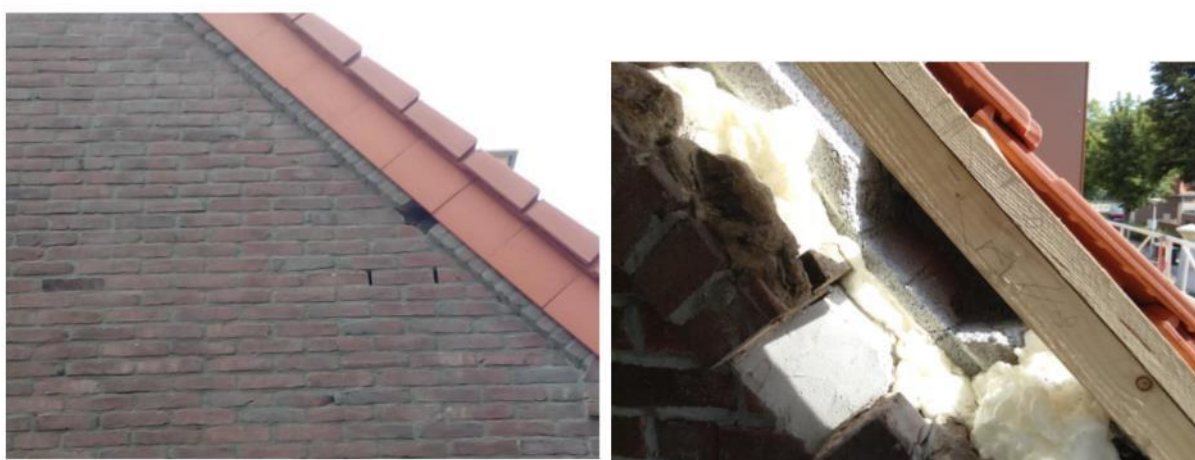
Figuur 7: Voorbeeld gierzwaluwverblijf via opening in rollaag naar ruimte onder kantpan. Bron: Arcadis.
