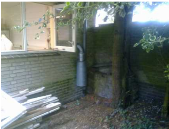
Foto 1. Achtergevel met demping op uitlaat
