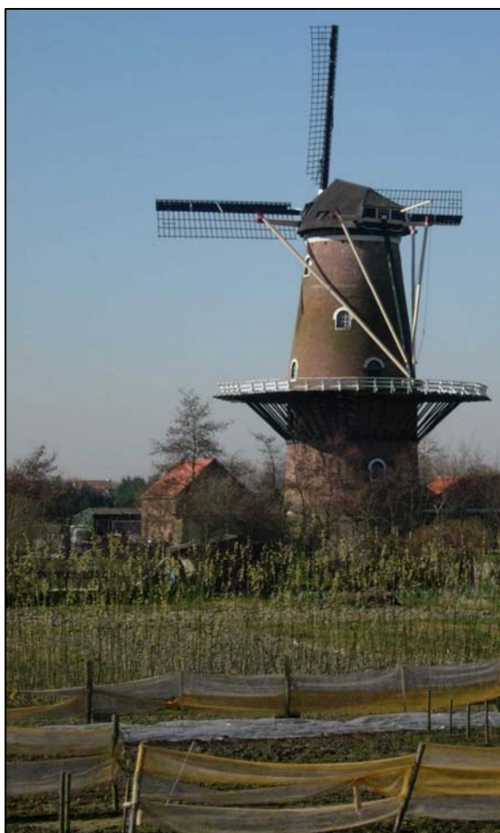
De Korenhalm in 's Gravenpolder met een stelling van 9,5 meter Fotograaf: Onbekend
