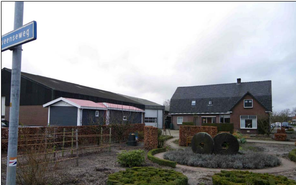
De plaats van de voormalige Puurveense molen, waar nu een grote schuur is neergezet.
