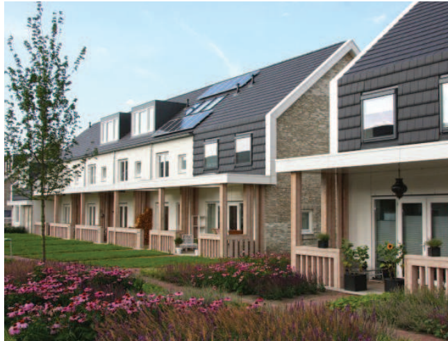
veranda's als aanbouw
