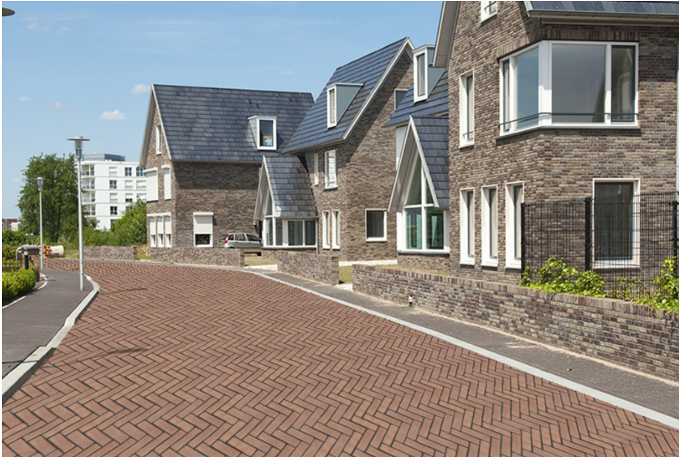
Referentie van een roodbruine klinker (Huwa – Ardeche DF) Parkeervakmarkering uitvoeren in een duidelijk contrasterende bruine steen, bijvoorbeeld de Dordogne of evt. Morvan (Huwa)
