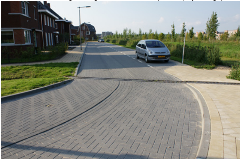
Referentie van een roostergoot door de rijweg heen, ten behoeve van de koppeling van de groene goot
