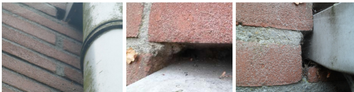
Foto: bovenkant regenpijp aan noordzijde.
