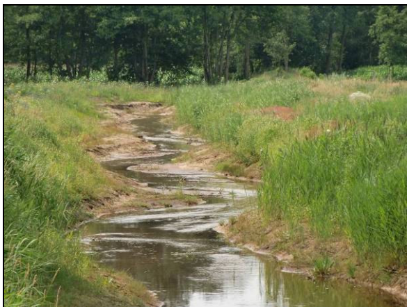
Net na aanleg: Een beek met een daaraan gekoppelde waterberging binnen een vast profiel met een lichte eroderende werking.
