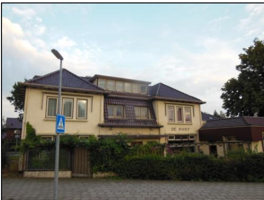
Figuur 3. Westelijk deel bebouwing.
