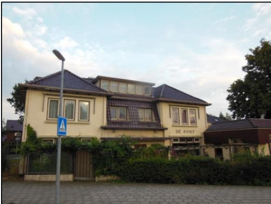
Figuur 3. Westelijk deel bebouwing.
