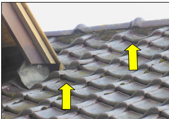
Figuur 10. Ruimtes onder dakpannen.
