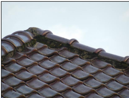
Figuur 8. Afgedicht dak.
