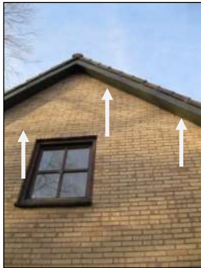
Figuur 3: Voorbeelden van openingen onder overstekende dakpannen en nokpannen (witte pijlen) van de aanbouw (foto: J. Lindenholz).
