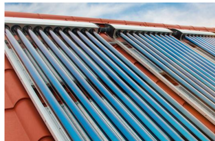
Afbeelding van zonnecollectoren. Door de buizen stroomt water dat wordt opgewarmd.
