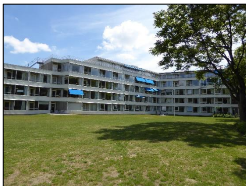
Het noordelijke gedeelte van het centraal gelegen gebouw;
