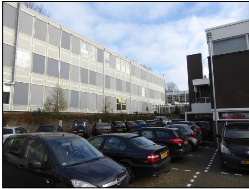
Binnenplaats met geschakelde gebouwen en toren.
