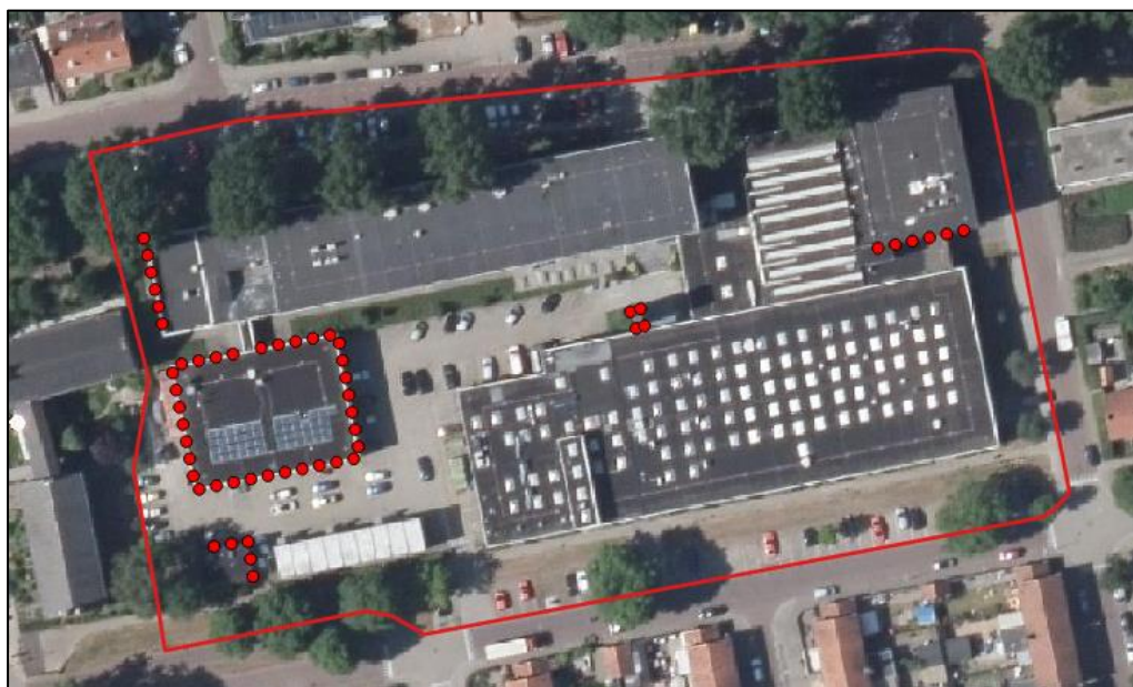
Luchtfoto plangebied (rood omkaderd), met de delen van de bebouwing die geschikt zijn voor verblijfplaatsen van vleermuizen (gestippelde lijn). Bron: PDOK.
