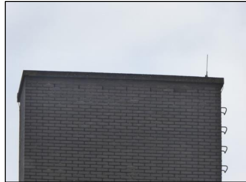
Open stootvoegen in stenen toren.
