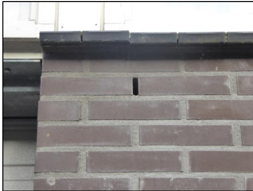
Open stootvoegen in deel van de bebouwing.
