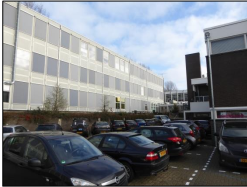
Binnenplaats met geschakelde gebouwen en toren.
