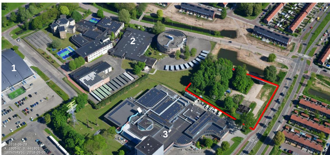
Figuur 3: Luchtfoto 2018: plangebied rood gemarkeerd met links de Rijnhal (1), linksboven het Olympus College (2) en onder het zwembad De Koppel (3)
