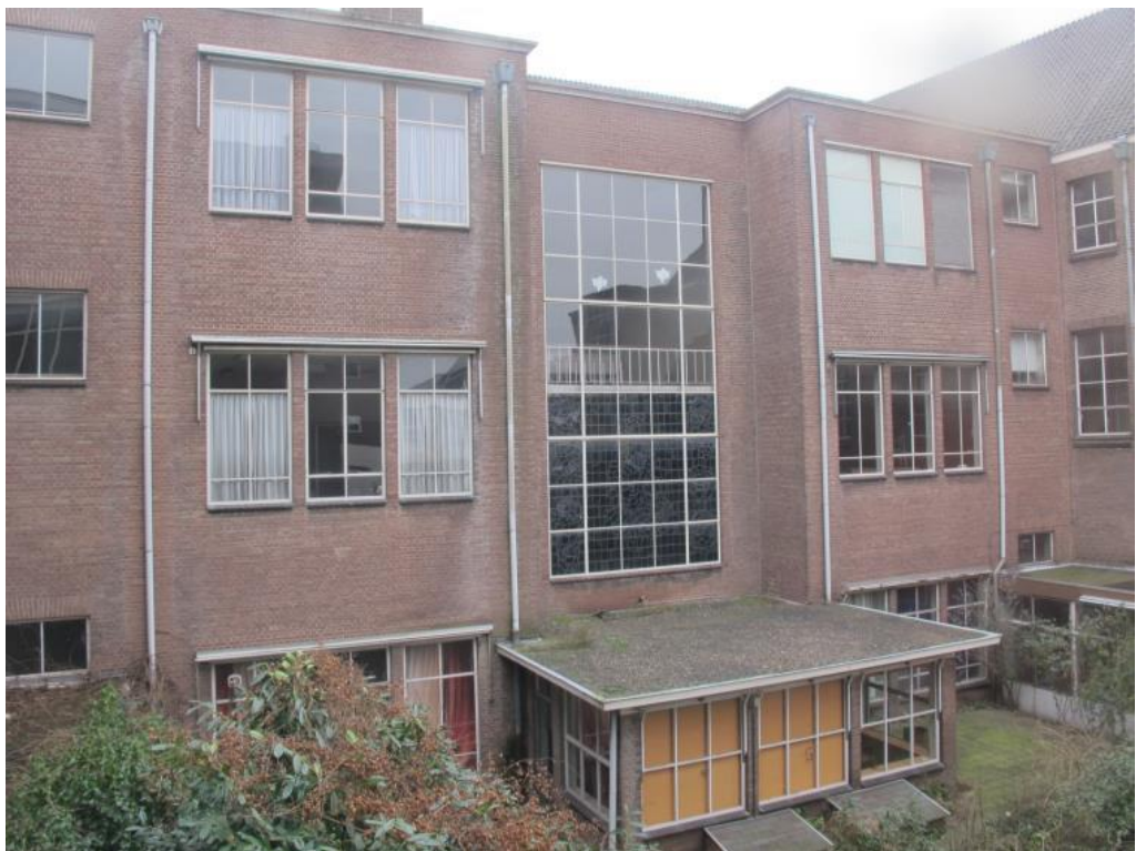
Zicht op de naoorlogse achtergevel van G. Feenstra (situatie voor sloop)
