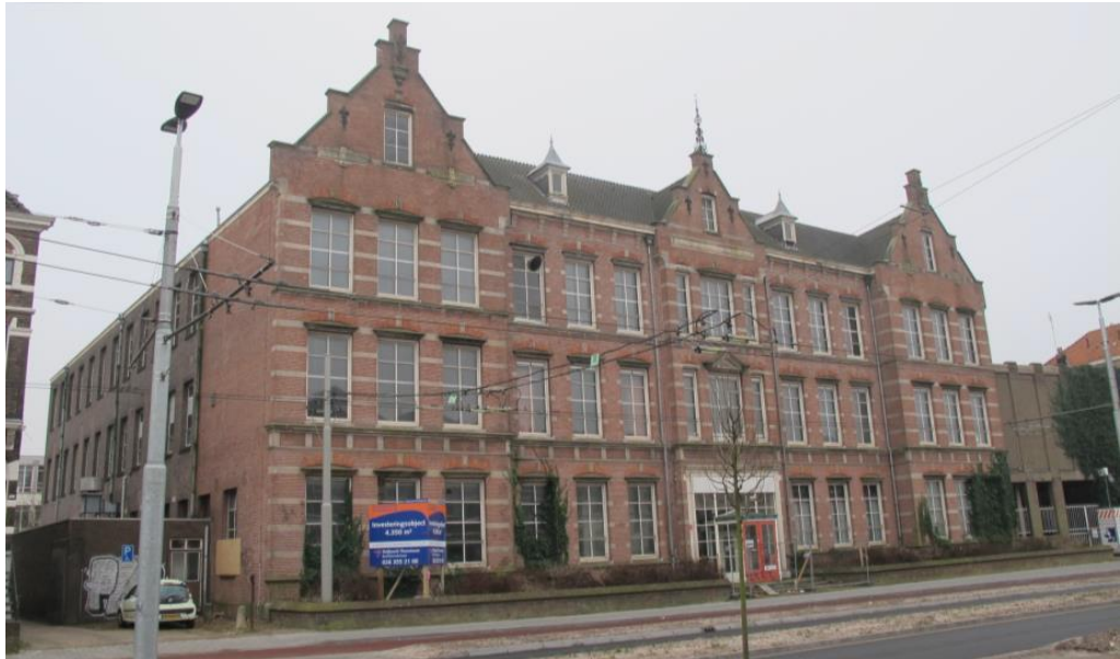
Zicht op de voorgevel
