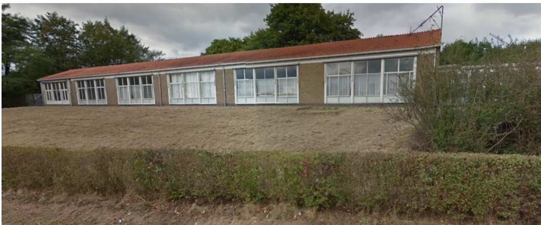
Figuur 5: Foto van het perceel vanaf de Dominee Bechtlaan (boven) en Burgemeester Bloemersweg (onder).
