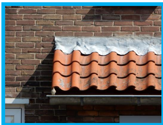
Onder afdak deuren
