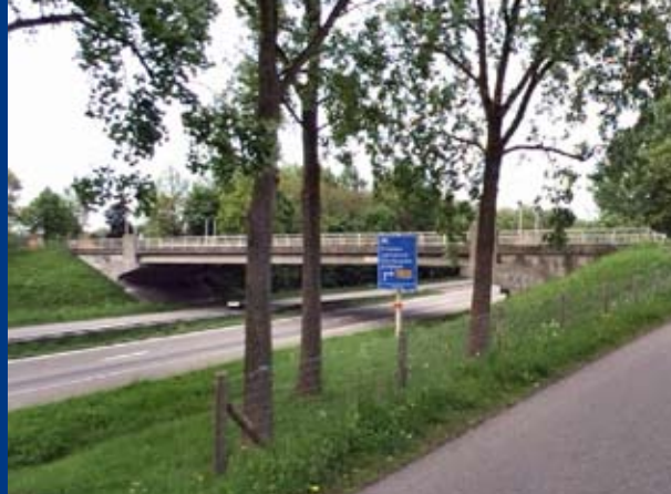
Bestaande brug over A325: sober en degelijk
