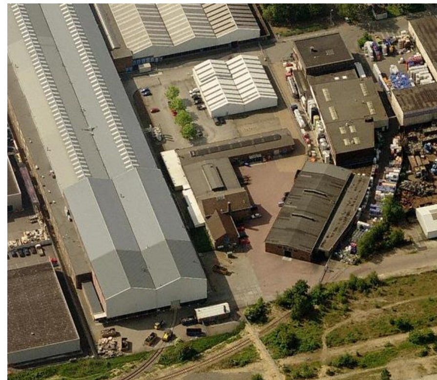
afb. 7 Industrie-ensemble, gezien naar het zuiden (bingmaps)
