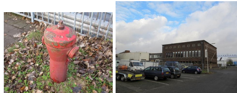
afb. 12 en 13 Links oude brandkraan aan de L.J. Costerstraat en rechts het voormalige kantoor van de Koninklijke Nederlandse Zuivelbond, L.J. Costerstraat 5.
