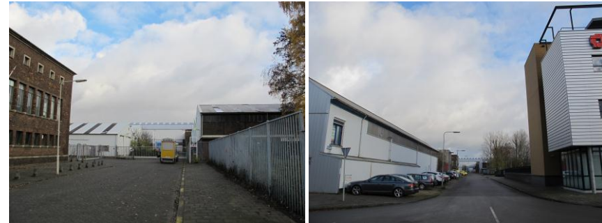
afb. 8 en 9 De L.J. Costerstraat in oostelijke richting. Op de linker foto links het gebouw van de Koninklijke Nederlandse Zuivelbond en rechts Rijnstaal.
