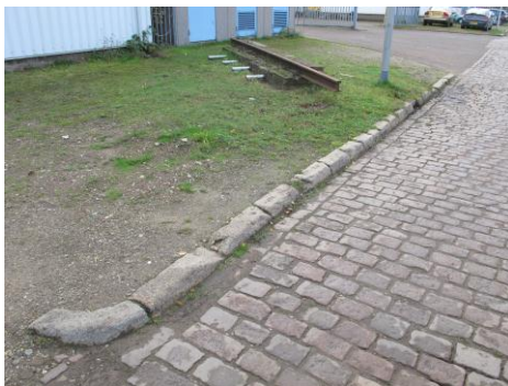
afb. 18 Detail oude bestrating van basaltkeien en bijbehorende banden.
