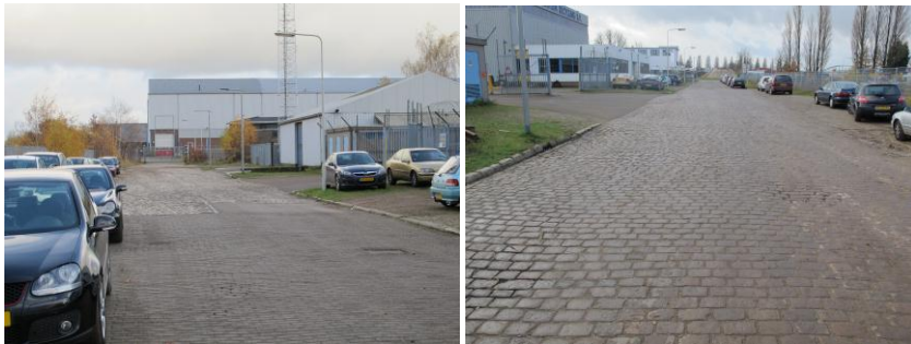
afb. 16 en 17 De Leeghwaterstraat in oostelijke en westelijke richting. Op de rechter foto is de oude bestrating met basaltkeien zichtbaar.
