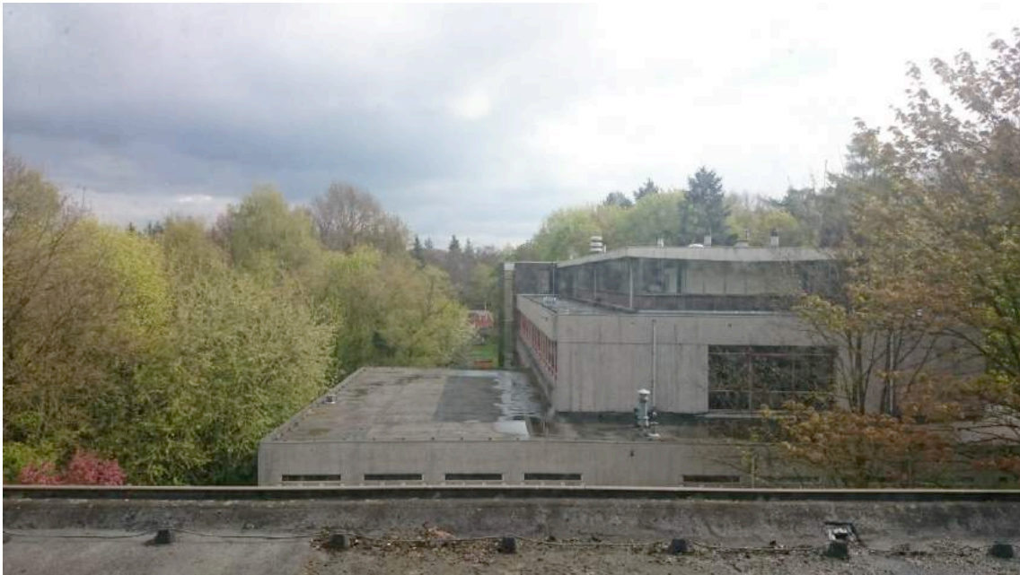
Het oostelijke kantoorgebouw, vanaf het dak van het westelijke kantoorgebouw. Foto: Anton van Meurs | Ecoresult B.V.
