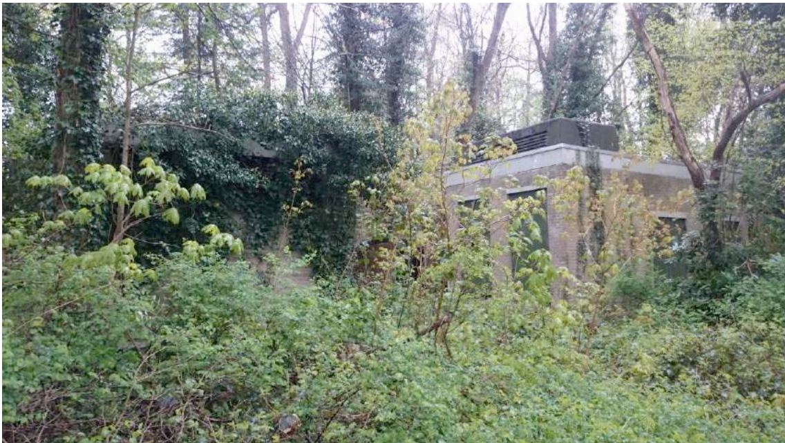
Schuur en trafogebouw in het plangebied. Foto: Anton van Meurs | Ecoresult B.V.
