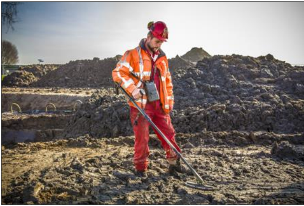
Figuur 5. Uitvoeren actieve realtime oppervlakedetectie en een staafdiagram waarop het maximale detectiebereik ( m^2 - maaiveld) per kaliber.
