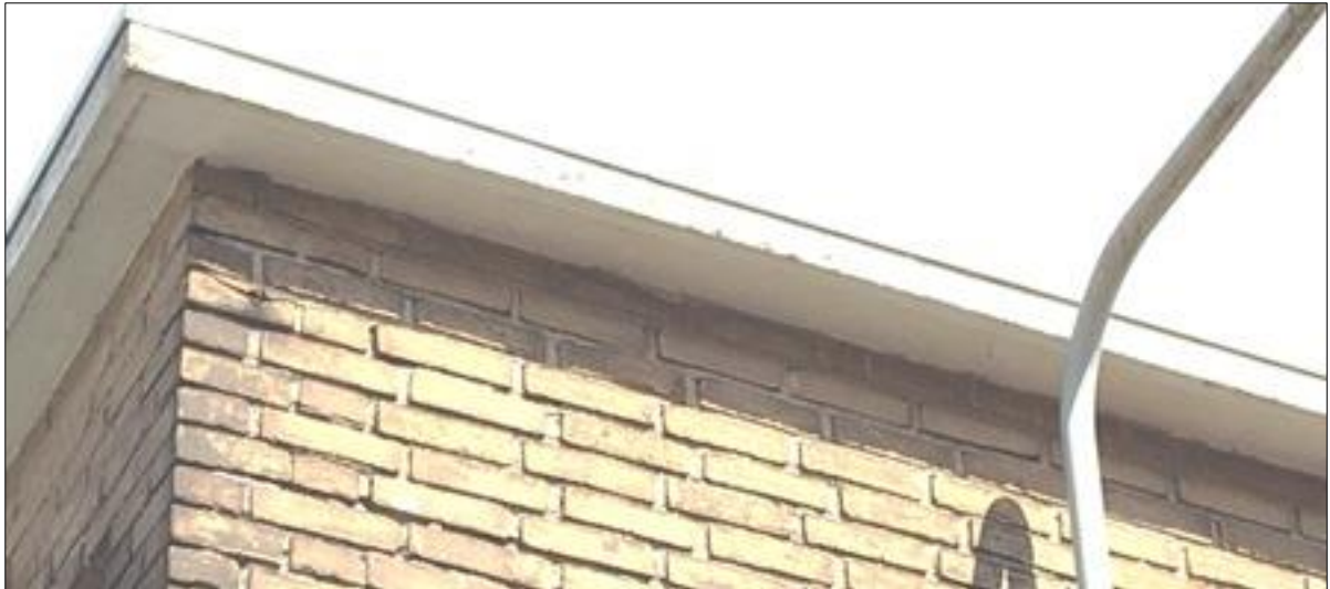
De betonnen overstek van de dakrand, sluit naadloos aan op de gemetselde buitengevels.
