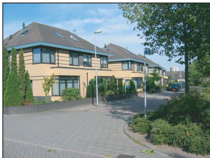
woningen aan de Belle van Zuylenbrink
