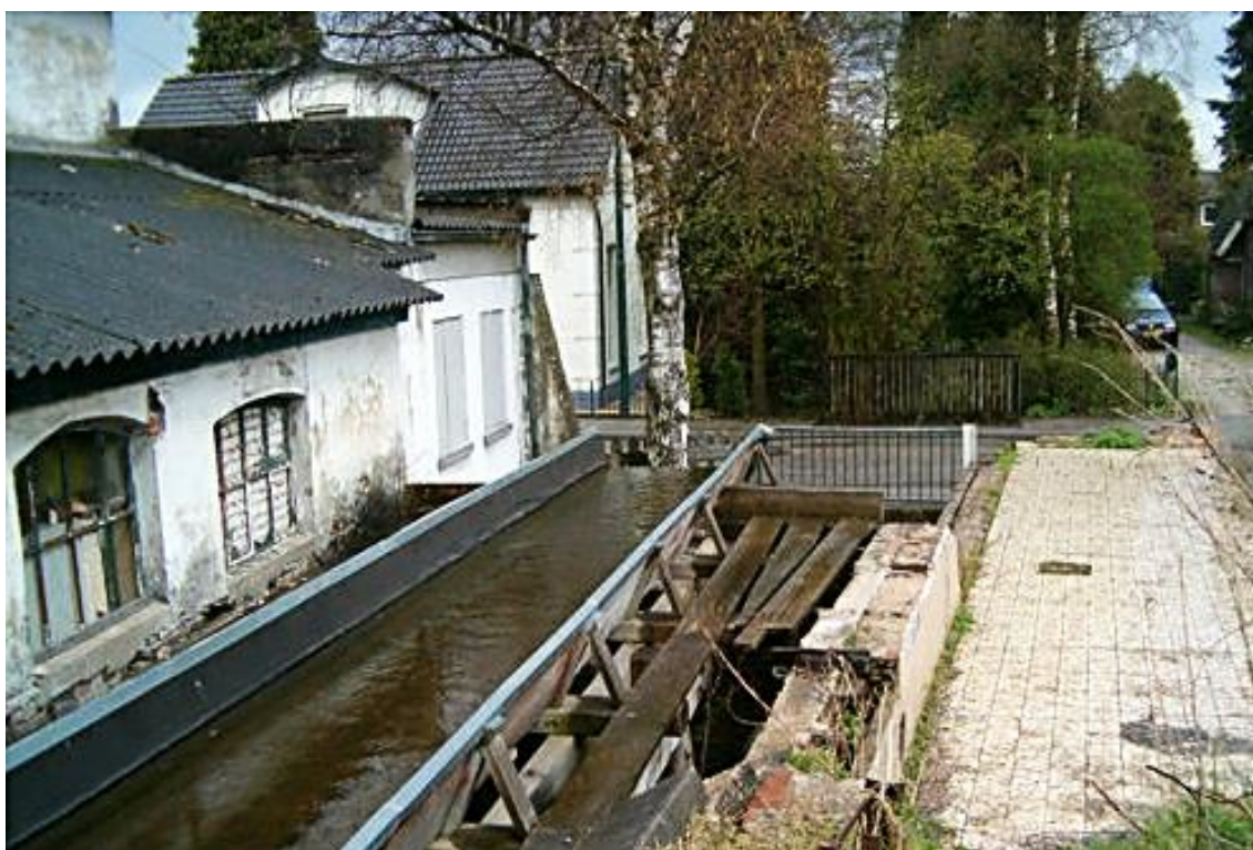
Afbeelding 2.11: De wassersij met een nieuw geplaatste watergoot. Aan de overzijde bevindt zich het dorpshuisje, G.P. Duuringlaan nummer 17, dat mogelijk gerelateerd was aan de wassersij. (Bron foto: www.molendatabase.org , M. Regelink, 23 oktober 2006)
