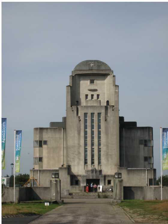
Figuur 4.1: Zendinggebouw A
