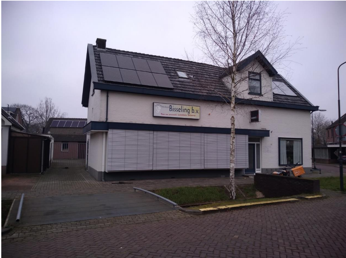
Afbeelding 15 ; Foto van het plangebied genomen vanaf de Frans van Mierisstraat richting het noorden.
