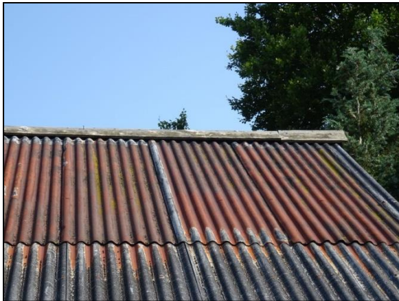
Figuur 15. De golflaten dakbedekking van de werkschuur.
