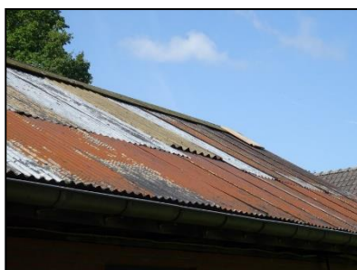
Figuur 7. De dakbedekking van de bebouwing betreft een enkele laag plaatijzer.
