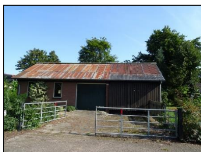
Figuur 3. Bebouwing op de onderzoekslocatie met golfplaten dak.
