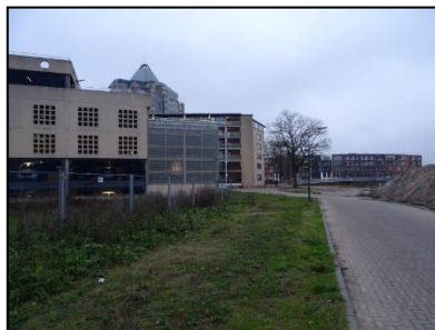
Figuur 7. De oostzijde van de parkeergarage welke aansluit op de Stadsgracht.
