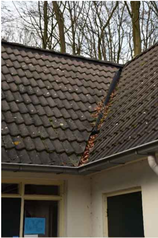
3. Scheefliggende of ontbrekende bladvangers.
