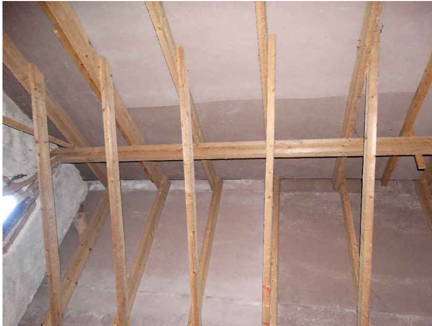
9 Detail dakbeschothout boven woongedeelte Boerenhoeve
