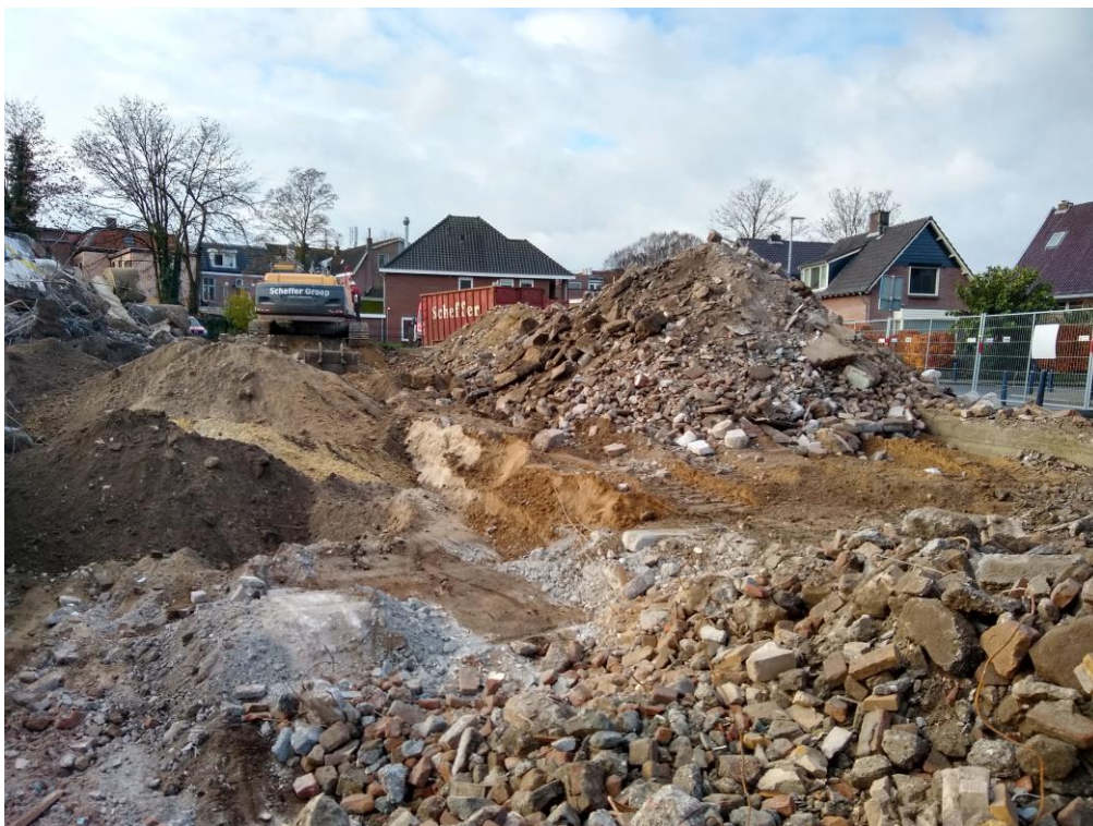
Figuur 5. Impressie van de sloopwerkzaamheden ter hoogte van boring 3, gezien richting het zuidwesten. Op de voorgrond is een betonnen funderingspaal zichtbaar.
