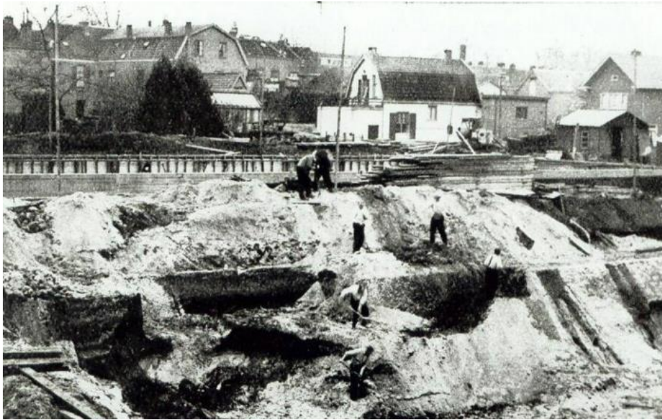
Figuur 3. Aanleg van het Sportfondsenbad in 1934. Het voormalige bad werd met de hand in getrapt talud uitgegraven. Bron: Beeldbank CODA Apeldoorn.
