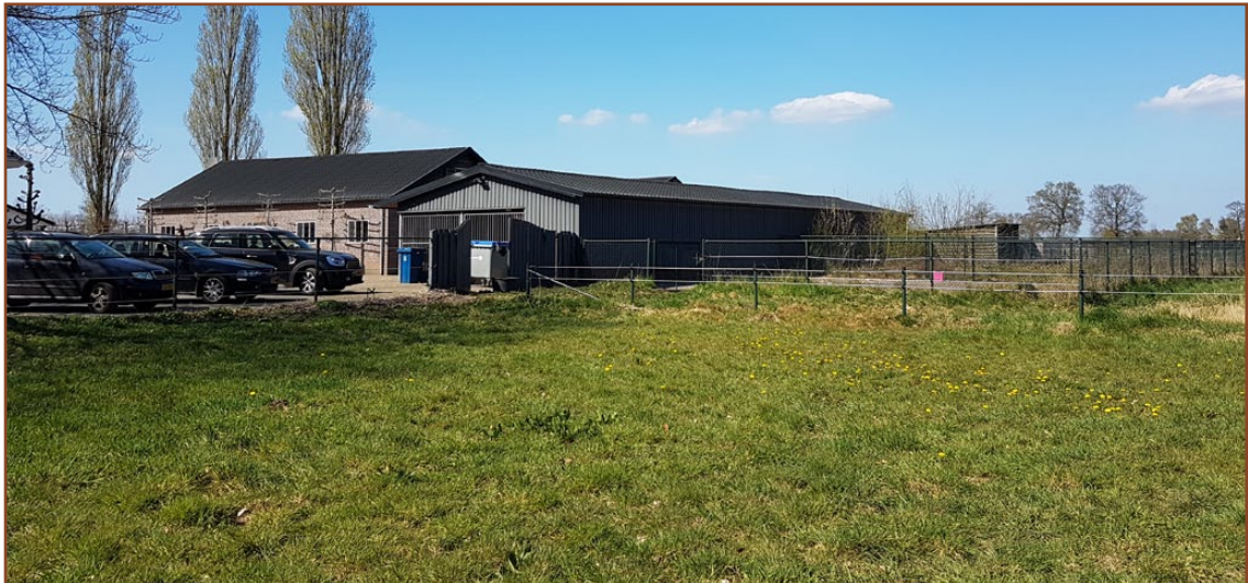
Afb. 2.1: Een gedeelte van het weiland waar nieuwbouw plaatsvindt (voorgrond), de te slopen paardenstal/berging gebouw E (rechts) en het te handhaven gebouw C.
