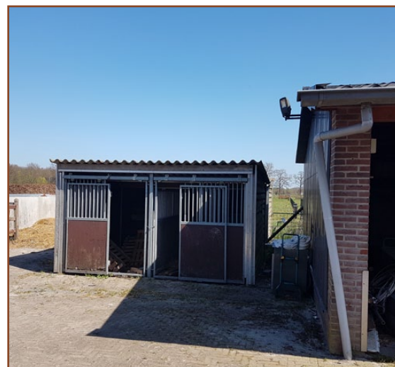
Afb. 2.10: Eén van de twee kleine stalletjes die gesloopt zullen worden.
