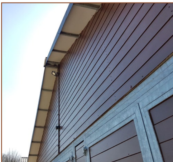
Afb. 2.4: Detail oostgevel stal D. De gevels bestaan uit enkellaags planken die strak aansluiten op het overstekende dakdeel. Er zijn geen mogelijkheden voor vleermuizen.
