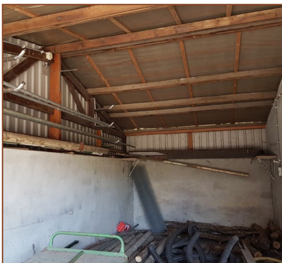
Afb. 2.9: Binnenkant van het noordelijk deel van gebouw E.
