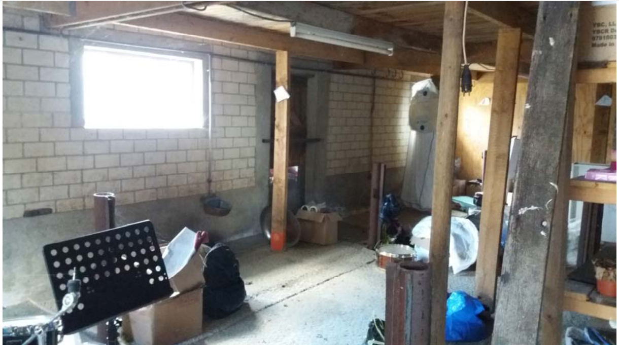
Foto 9: binnenzijde te slopen bebouwing
