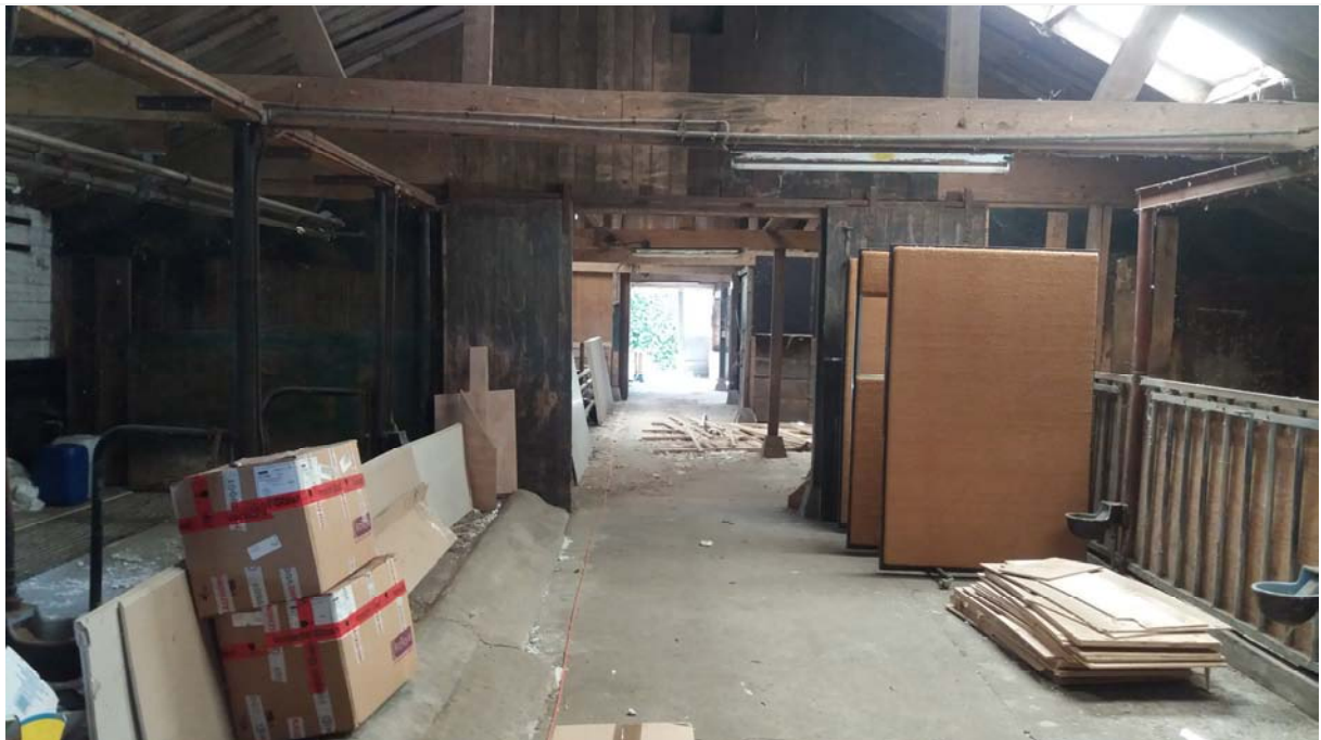
Foto 11: binnenzijde te slopen bebouwing
