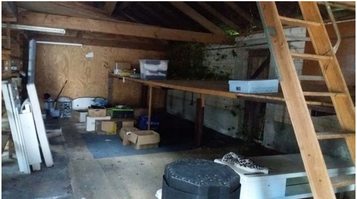
Foto 10: binnenzijde te slopen bebouwing
