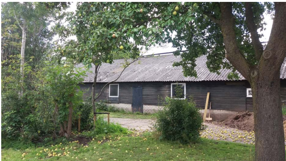
Foto 8: te slopen bebouwing
