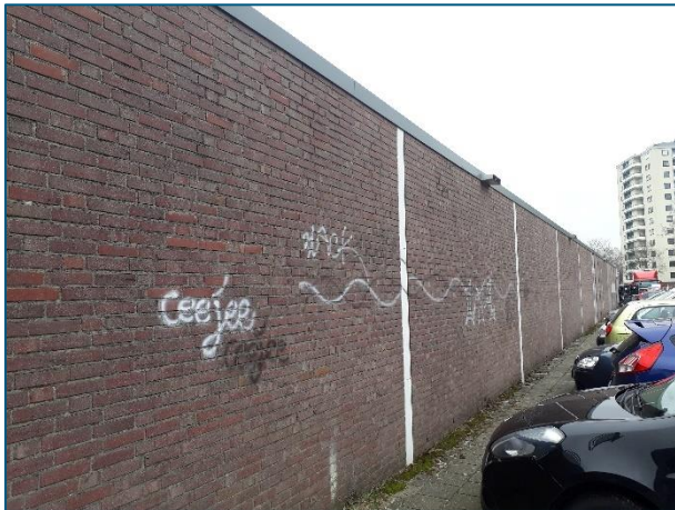
Figuur 4-4. De laagbouw aan de zuidzijde van het winkelcentrum. Er zijn geen stootvoegen aanwezig. Het dak rust direct op de muur. Er is geen indicatie dat er ruimte achter de muur of onder het dak is voor vleermuizen. Foto's: RHDHV, 2019.
