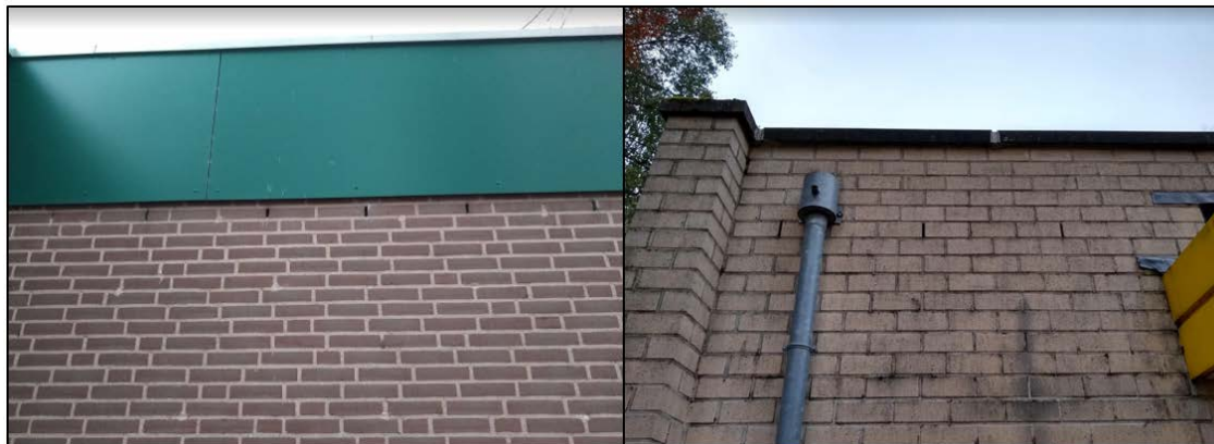
Figuur 3.3 Gevels van het schoolgebouw. De gevels beschikken over stootvoegen die mogelijk toegang bieden tot geschikte verblijfplaatsen in een spouwruimte
