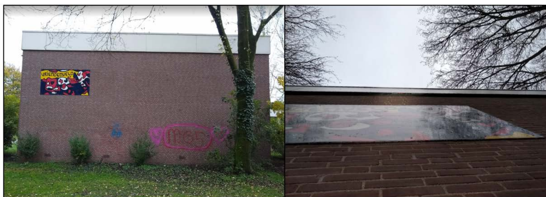
Figuur 3.4 Gevels van het gymzaalgebouw. De dakrand beschikt over openingen die mogelijk toegang bieden tot geschikte verblijfplaatsen in de spouw, onder het dak en/of achter de dakrand
