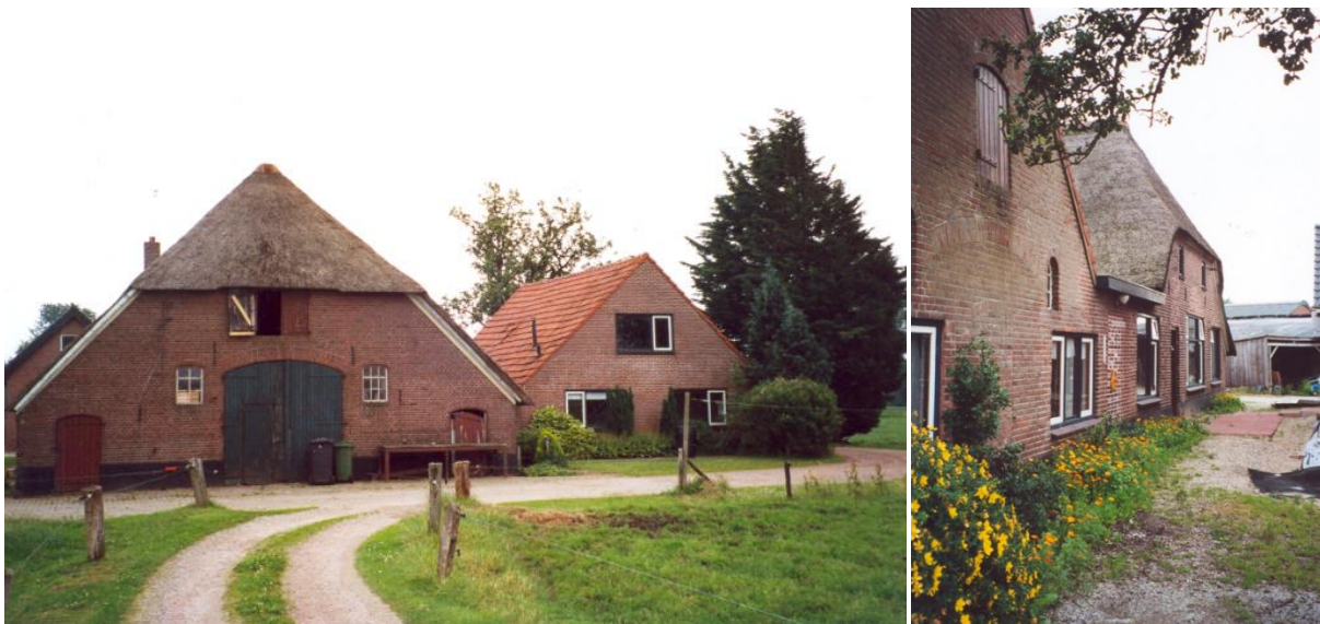
De in 2002 afgebroken woonboerderij met aangebouwde woning aan de zuidzijde, foto's genomen vanuit noordwestelijke (links) en zuidelijke richting (bron: www.coda.nl )
