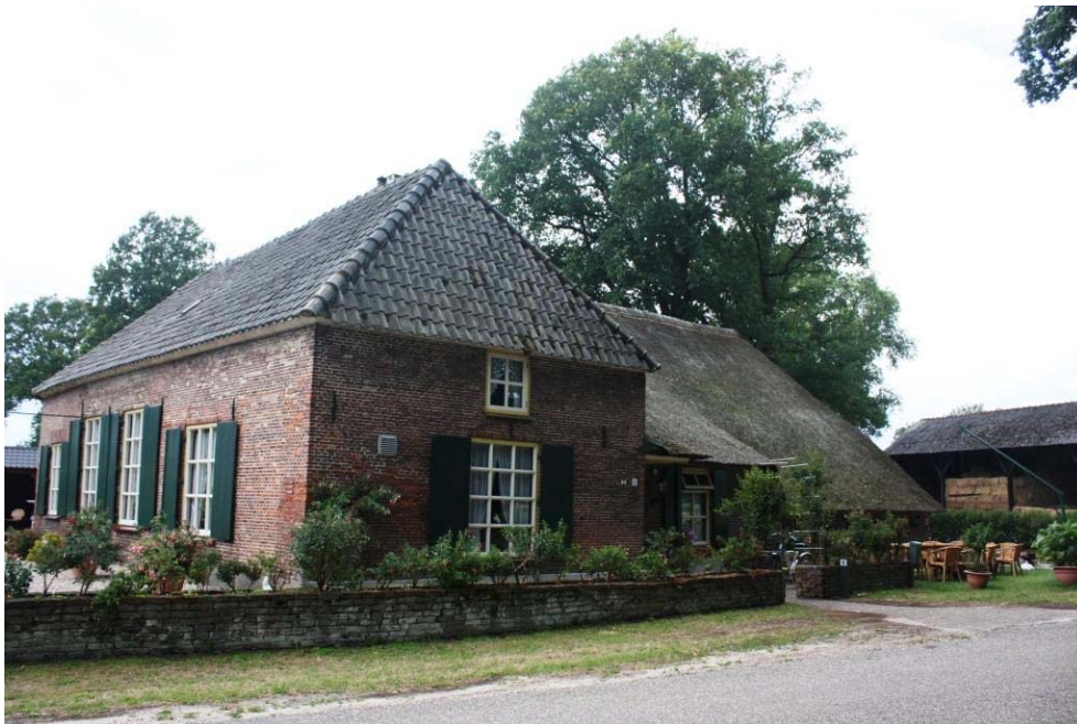
Afbeelding 33 Het woongedeelte van de 18 de -eeuwse boerderij aan de Buurtweg 8 te Meerveld is dwars op het bedrijfs gedeelte geplaatst. Kenmerkend is dat het dak van het woongedeelte is gedekt met pannen, terwijl het bedrijfs gedeelte is voorzien van een rieten kap.
