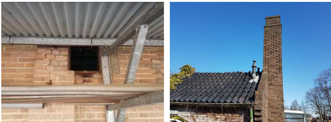
Figuur 4.4.1-2: Voor vleermuizen geschikte bebouwing op het terrein van de gemeentewerf.
