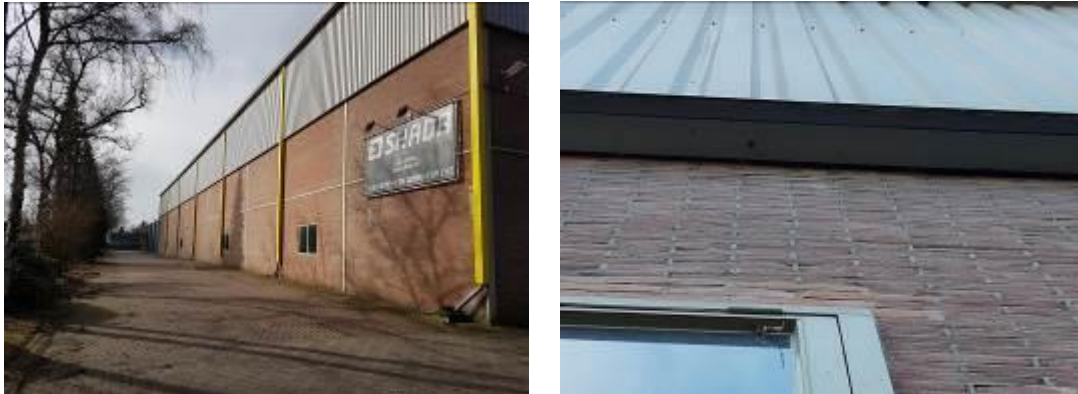
Figuur 4.4.1-1: Voor vleermuizen geschikte bebouwing op het terrein van de gemeentewerf.
