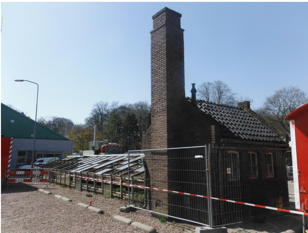
Figuur 12 De broeikas met bijbehorend stookhuis. Vanuit de kelder van het stookhuis is een ondergrondse verbinding waargenomen richting de ten oosten gelegen funderingen in proefsleuf 7.
