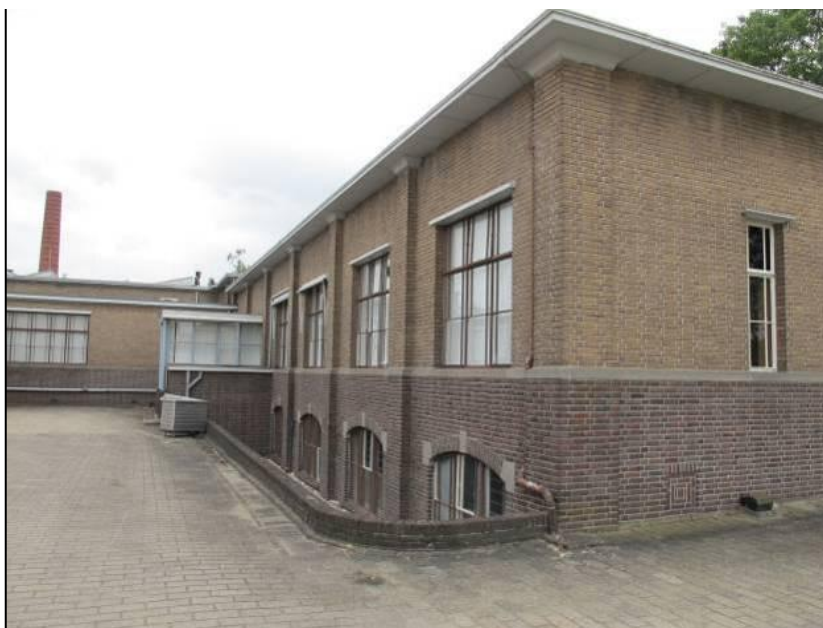
Fig. 2.13: Zicht langs de oostgevel van gebouw 21/21 (bron: Van Meijel en Opmeer 2004).
