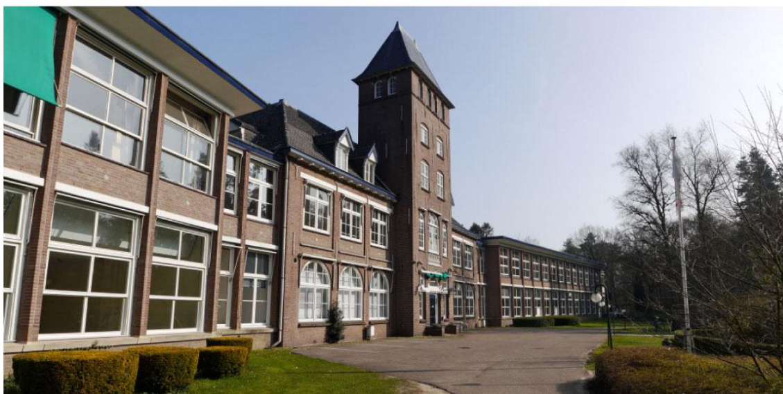
Abbeelding 4: Optie 3 – verpleeghuis Het Immendaal, Beekbergen, de foto is van de zuidgevel van het hoofgebouw
