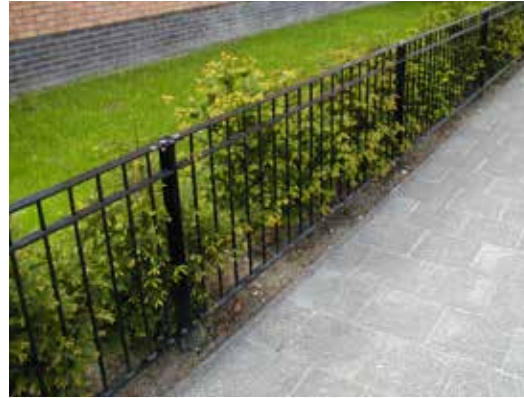
Laag hekwerk ondersteund met groen voorzijde
