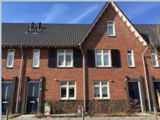
Ramen en deuren in een logische verhouding
