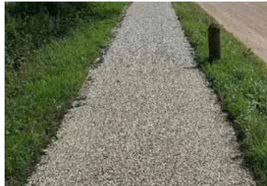
Asfalt met parelgrind, langzaamverkeerroute zorgveld
