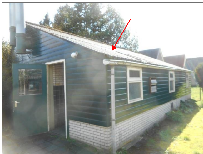
Foto 7: Schuur: Golfplaten dak (M02AA)
