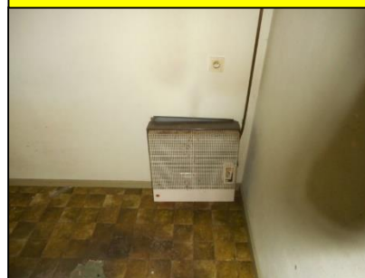
Schuur: Gevelkachel (M05O)
