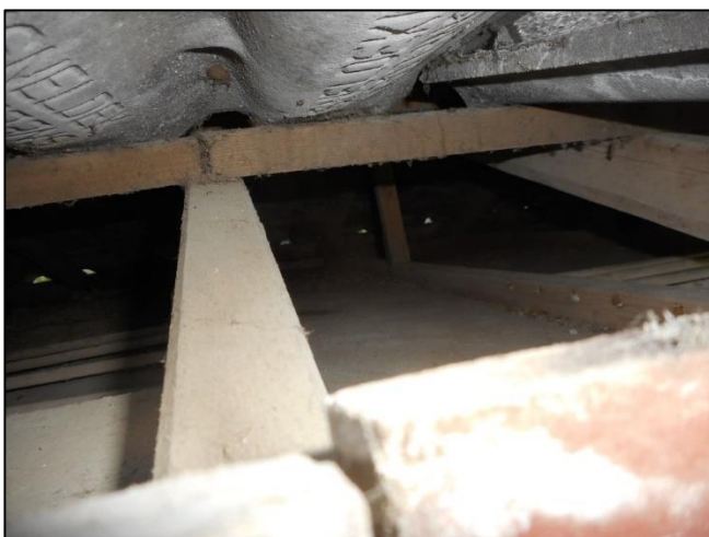
Foto 5: Duivenhok: Onder dakpannen
