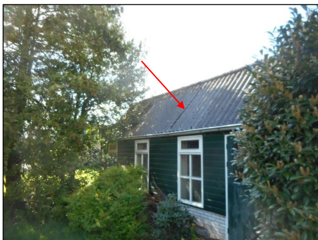
Foto 9: Schuur: Golfplaten dak (M02AA)
