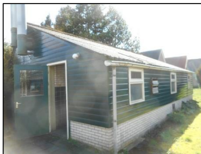
Schuur: Golfplaten dak (M02AA)
