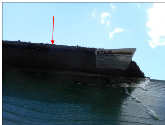
Foto 8: Schuur: Golfplaten dak (M02AA)
