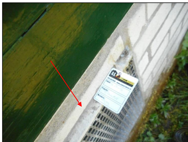
Foto 10: Gevel van schuur: Vlakke plaat (M03AA)
