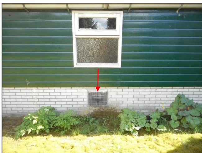
Foto 11: Gevel van schuur: Vlakke plaat (M03AA)
