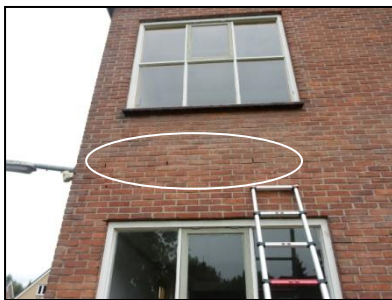
Figuur 10. Stootvoegen oostzijde bebouwing.
