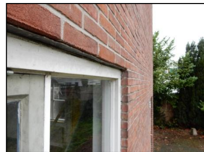
Figuur 12. Detailfoto kozijn, geen ruimtes die toegankelijk zijn voor vleermuizen.
