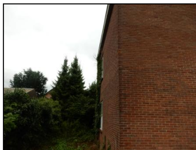
Figuur 7. Westzijde bebouwing.
